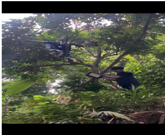
Gambar 1. Pemasangan Lampu Tenaga Surya di Desa Sambilawang, Kecamatan Waringin Kurung, Kabupaten Serang
