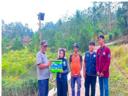
Gambar 2. Penyerahan dan Pemasangan Lampu Tenaga Surya di Desa Sambilawang, Kecamatan Waringin Kurung, Kabupaten Serang
